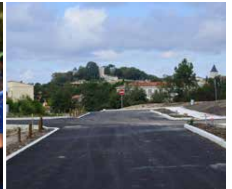
T comme Tivoli : la viabilisation est terminée et les premières constructions sortent de terre.
