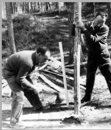
Jean Marcelly ( à gauche ) et M. Haies plantent des pieux pour soutenir la berge du lac en 1960.
