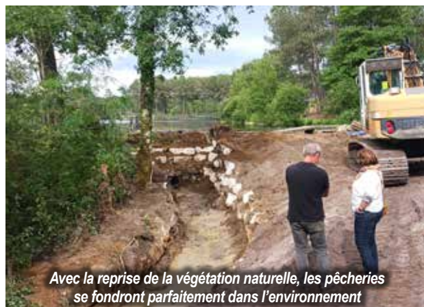
D'impressionnants travaux avec notamment un spectaculaire enrochement.
