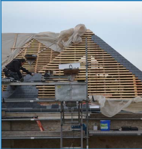
A comme les A rdoises d' A ngers de la toiture du centre culturel
