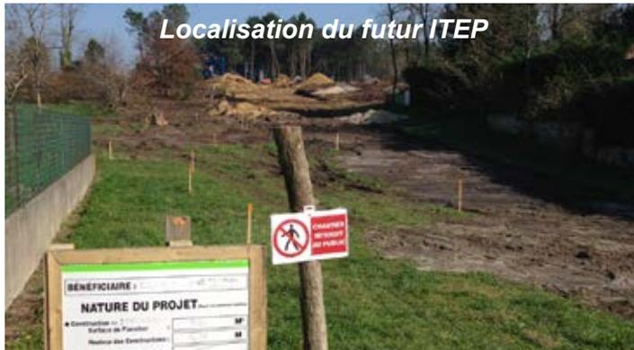
Les travaux de viabilisation du futur quartier Tivoli sont bien engagés : passage des réseaux (électriques, eau potable, France télécom, réseau d'assainissement des eaux usées, etc.). Le terrassement des voiries et des noues est achevé et les opérations de retraitement des sols terminées ainsi que la couche d'imperméabilisation. Les travaux de construction de l'ITEP ont commencé début mai.
