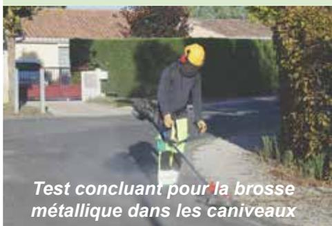
Test concluant pour la brosse métallique dans les caniveaux
